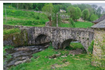
Saint-Chély-d'Aubrac : pont des Pèlerins
